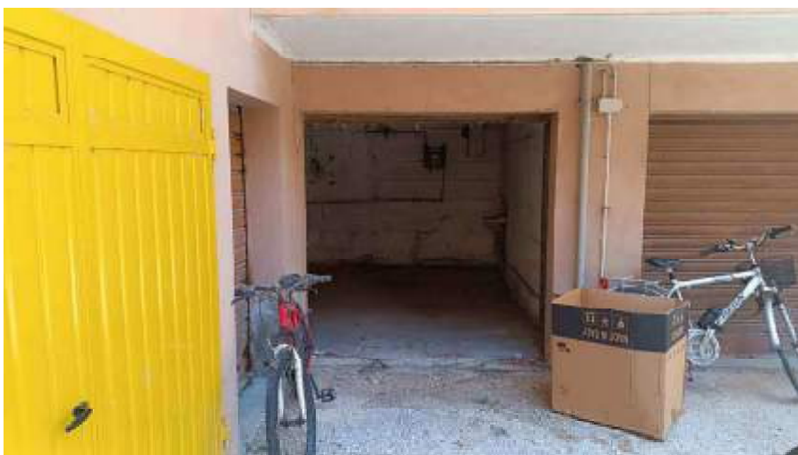
006 - PARTICOLARE ACCESSO MAGAZZINO
